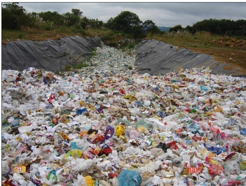
Figura 4 - Vala para disposição de rejeitos, aterro sanitário de Urubici. Fotografia feita em 21/05/2009. Créditos: Francisco Áureo.
